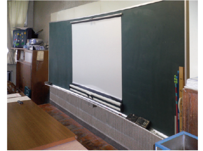
昇降装置に黒板を設置した例。
