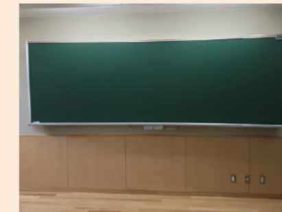
普通教室に曲面黒板を設置した例です。
