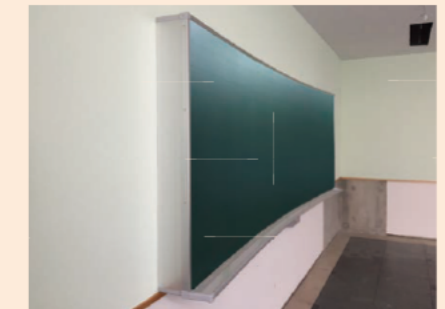
普通教室の曲面黒板です。教室の端からでも湾曲により光の反射が抑えられて見やすいことが特長です。
